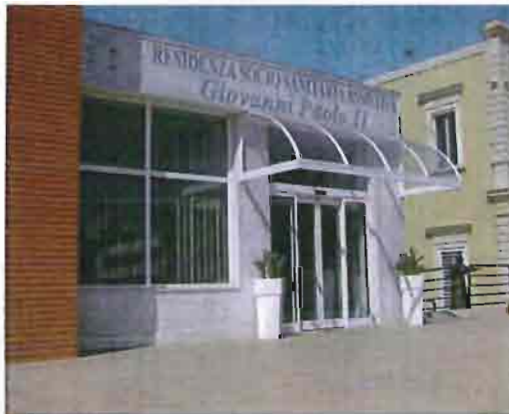
L'ingresso della sede del Centro risvegli a Capurso
