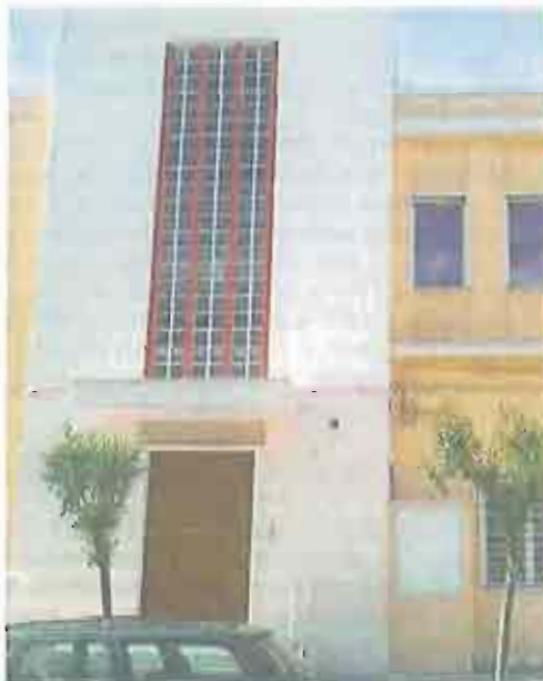
MODUGNO La palazzina dell'Oratorio San Giovanni Bosco, in via X Marzo
