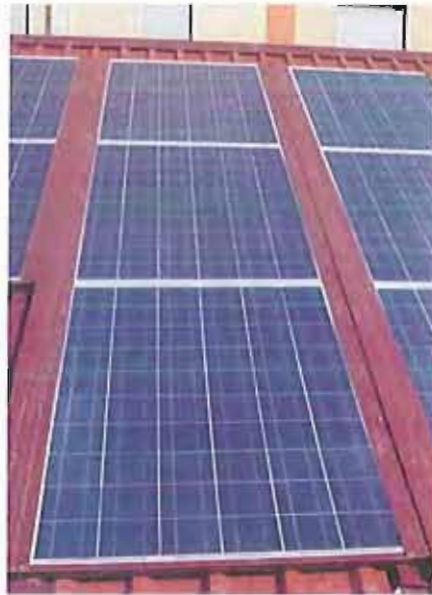
pannelli solari integrati in un tempo di una mansarda AndriaLive
