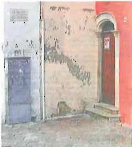
CENTRO ASCOLTO La sede di via Matteotti, 24
