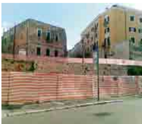
CANTIERE Via La Marina
