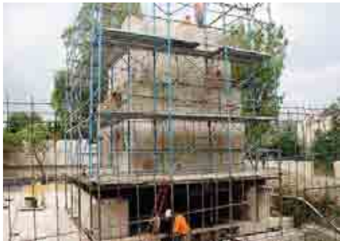
LA PIRAMIDE DI CEMENTO Servirà a collaudare i pilastri interrati
