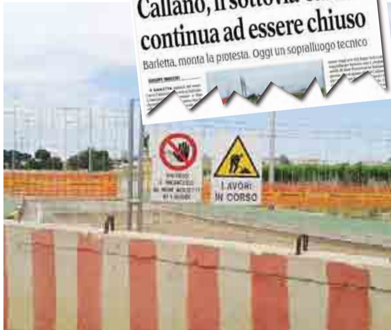
LAVORI IN CORSO Ma quando finiranno definitivamente i lavori?
