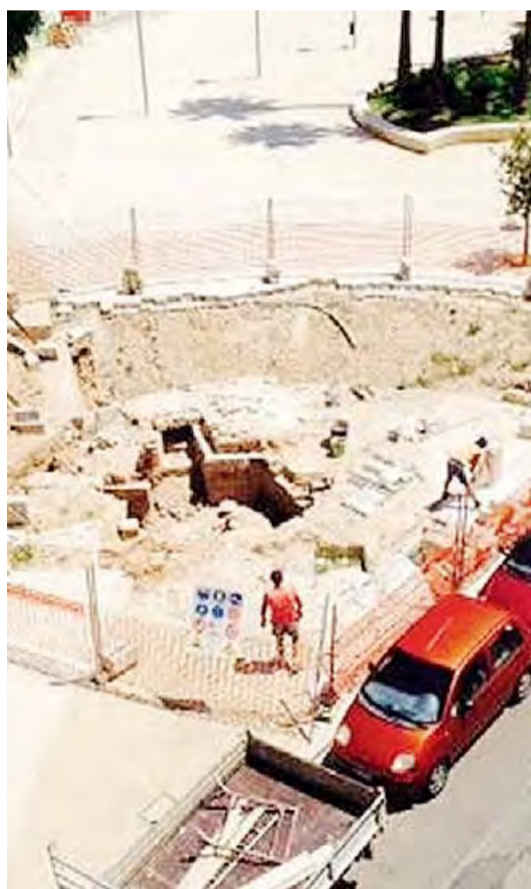
MONOPOLI Il cantiere di piazza XX Settembre
