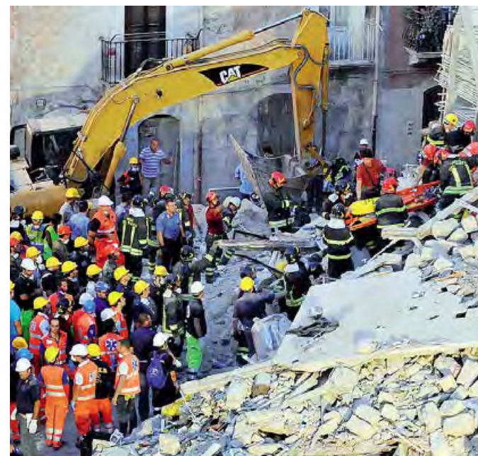
3 OTTOBRE 2011 Soccorritori sul luogo del crollo [foto Calvaresi]
