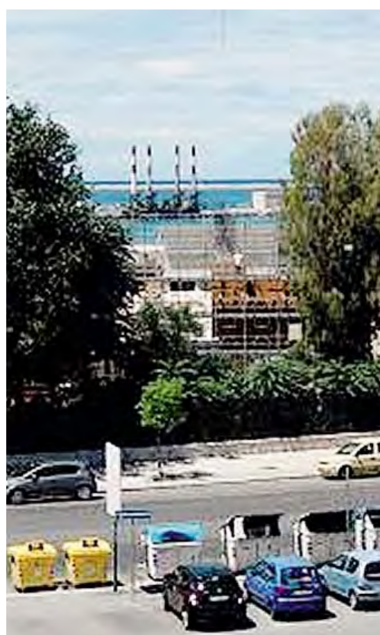
IL CANTIERE La palazzina in costruzione
