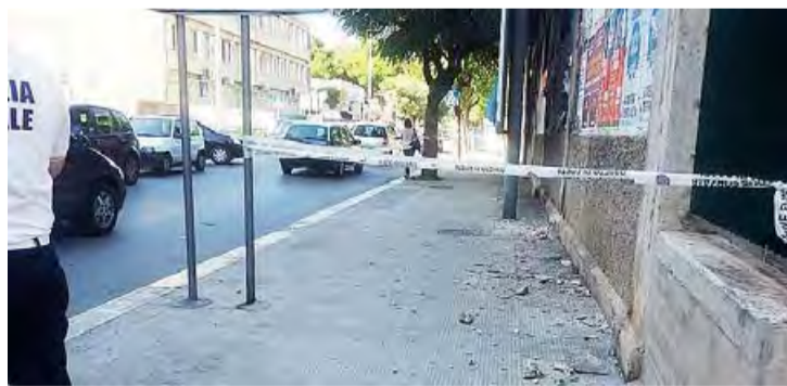
IL TRATTO INTERESSATO Nella zona di via Sant'Agostino
