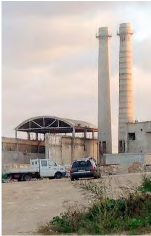
EX CEMENTERIA Presto la demolizione delle torri
