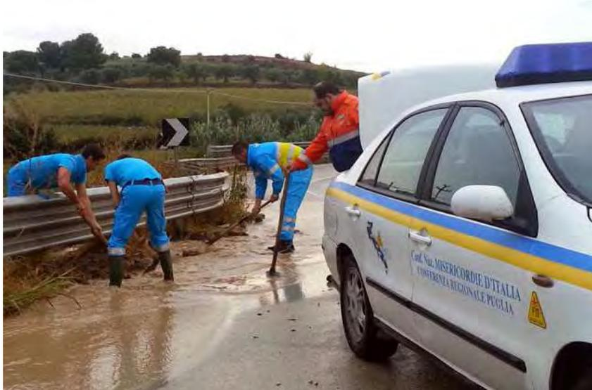
Sono stati creati canali di scolo appositi ai bordi dei due assi viari oltre all'aspiramento di acqua in diversi punti per diminuire il carico giunto sino alla strada e pericoloso per le tante autovetture in transito.
