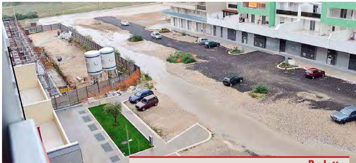
FORTI RITARDI Nella realizzazione delle opere di urbanizzazione primaria nella nuova 167
