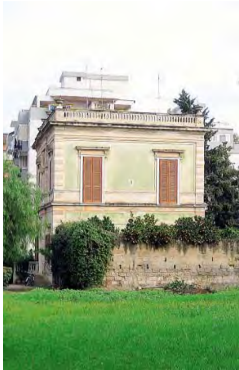
CHIUSA Villa Guastamacchia in ristrutturazione
