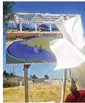
Il cantiere della pista di atletica
