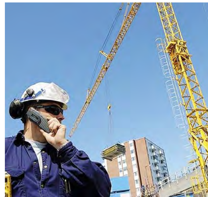
LAVORO Operaio in un cantiere
