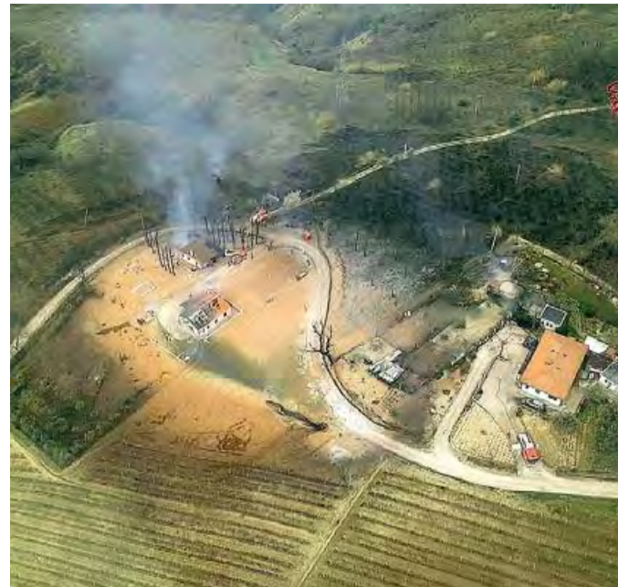
PINETO Il tratto di metanodotto esploso in una foto aerea dei Vigili del fuoco
