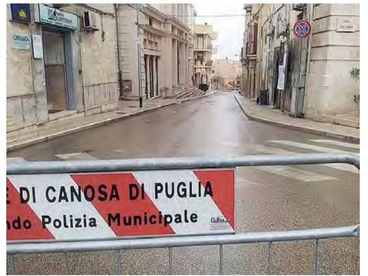
ARTERIE CHIUSE Per le conseguenze dei recenti cedimenti nel sottosuolo
