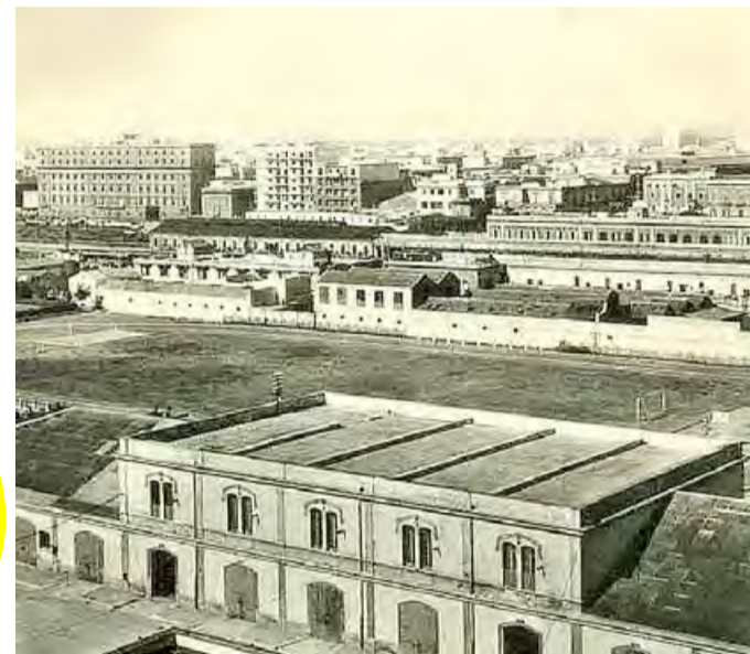
EX CASERMA ROSSANI La palazzina Comando in una immagine storica
