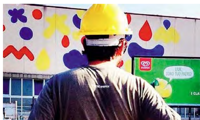
Dopo lo stadio «San Pio» oggi tocca alla parete d'ingresso delle piscine
