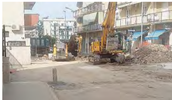
QUARTIERE SEMINARIO Lavori in corso
