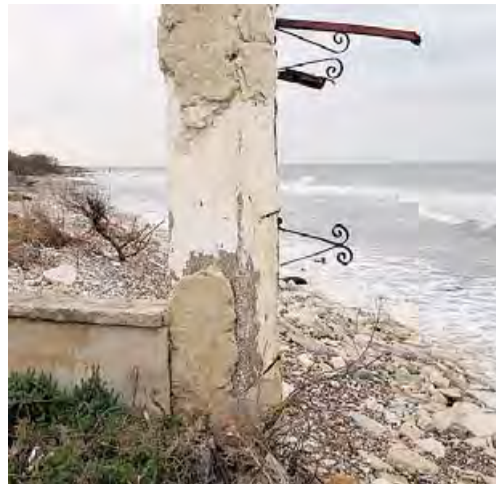
IN ARRIVO Un argine all'erosione marina
