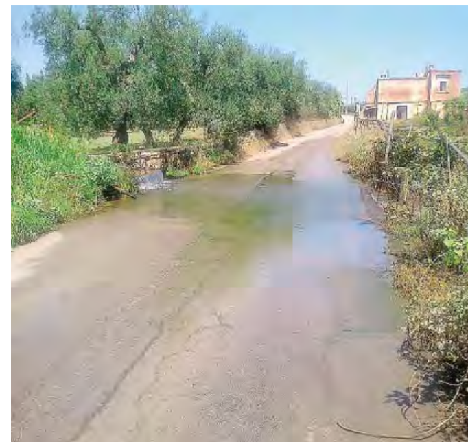
LA STRADA Nei pressi della lama, è spesso invasa dai liquami
