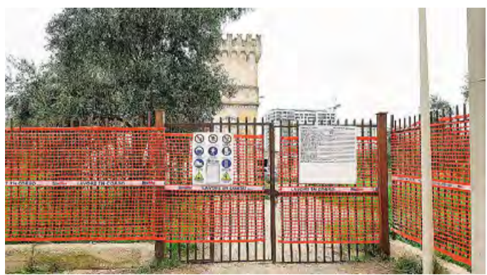
POGGIOFRANCO Il cantiere del Villaggio dell'Accoglienza [foto Luca Turri]
