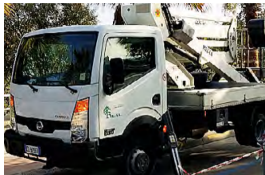
PULITURA Un mezzo utilizzato per i lavori
