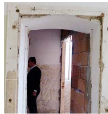
LAVORI IN CORSO Nella sede
