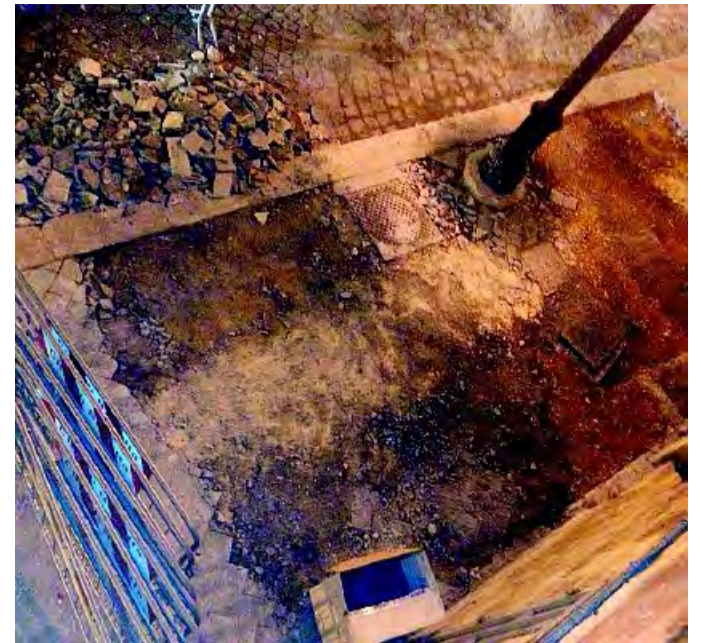
LAVORI IN CORSO Il marciapiede di corso Cavour
