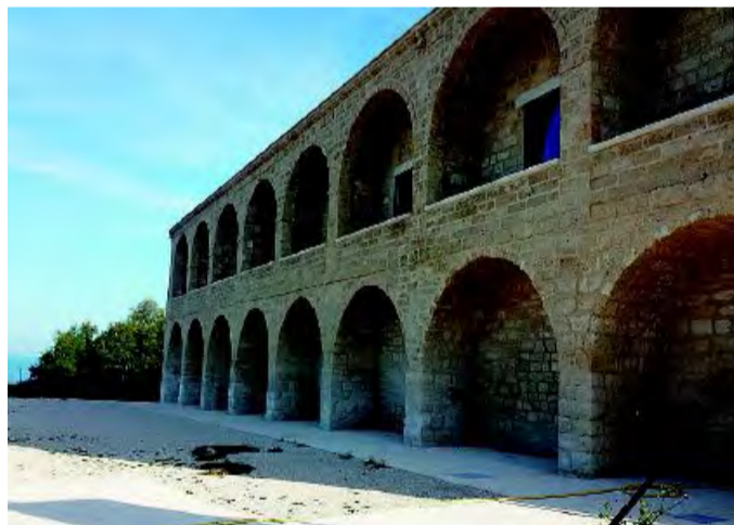
RESTAURATO Il monastero di Colonna
