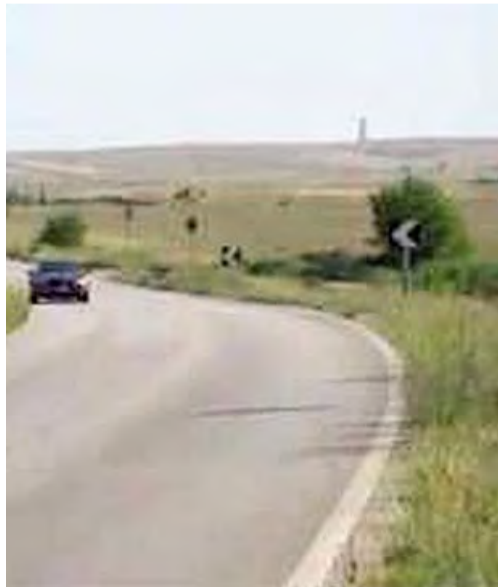
PERICOLOSA Un tratto della Altamura-Cassano
