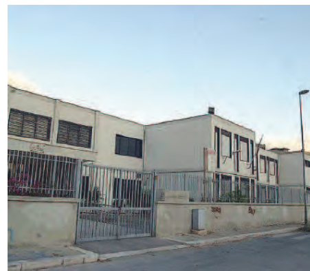
CARBONARA L'ingresso dell'istituto comprensivo «De Marinis»
