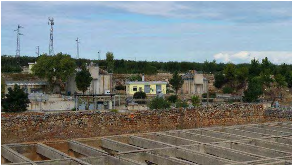
Discarica di via Belloluogo e depuratore, rifiuti e cattivo odore a cielo aperto © CoratoLive.it
