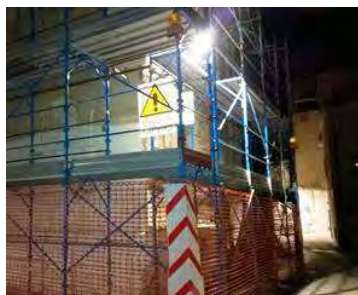
Il cantiere della chiesa di San Salvatore © val nin
