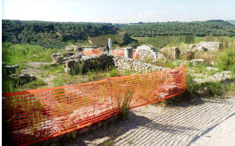
Lavori in corso a Canne © Nino Vinella
