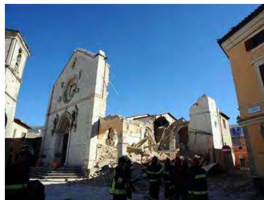
I danni del terremoto a Norcia © Il Fatto Quotidiano
