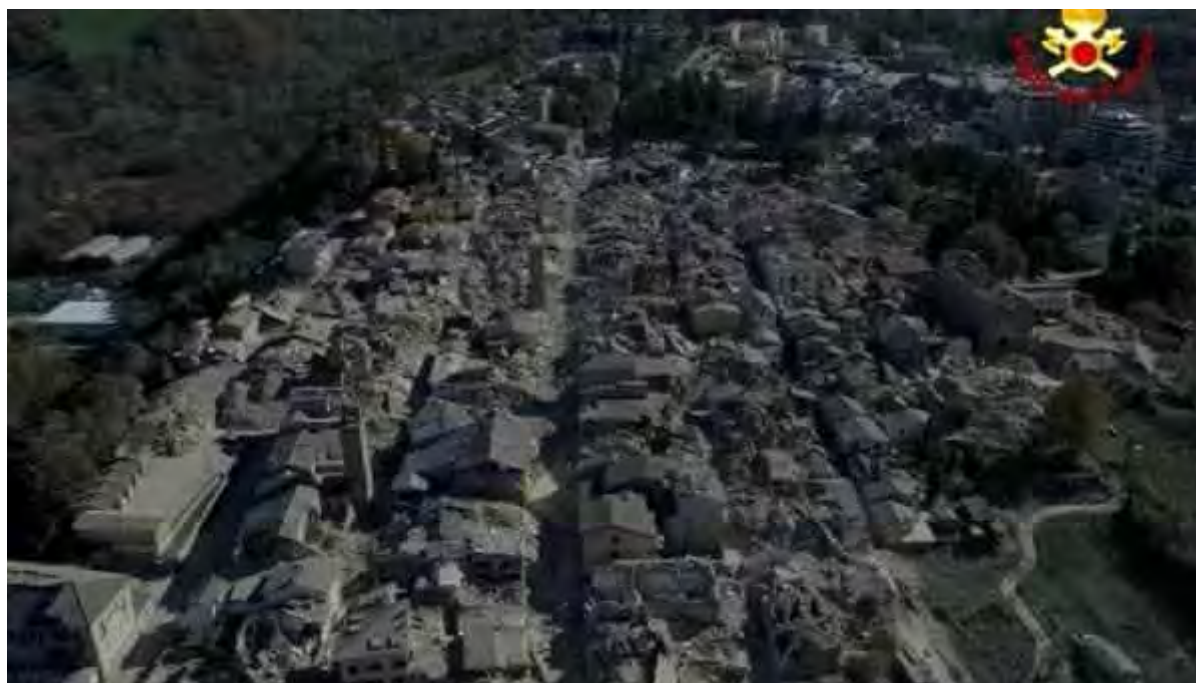
La distruzione ad Amatrice - Foto da Today.it
