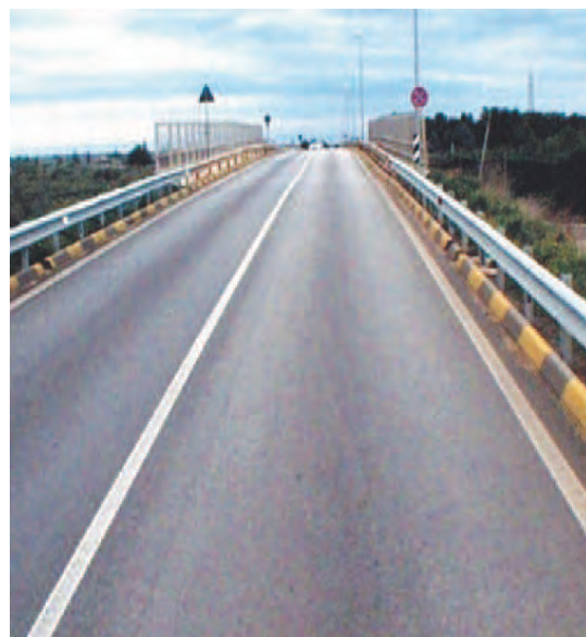
VIABILITÀ Il cavalcavia autostradale sulla s.p. Bisceglie - Corato
