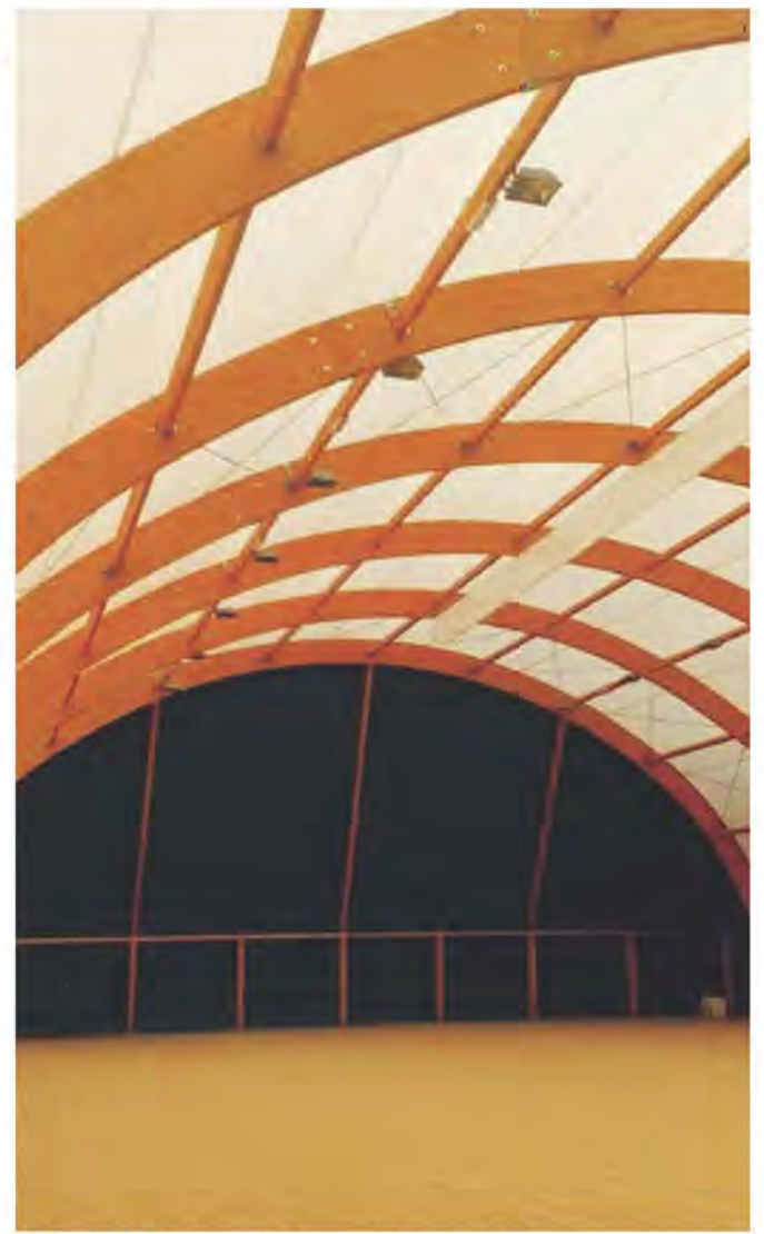
MONOPOLI L'interno dell'impianto tensostatico
